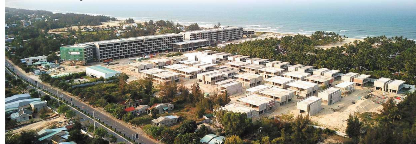
Dự án Malibu Hội An đang trong tiến trình xây dựng
